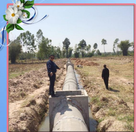
โครงการก่อสร้างวางท่อระบายน้ำ คอนกรีตเสริมเหล็กบ้านนาฝายหมู่ที่ 2
