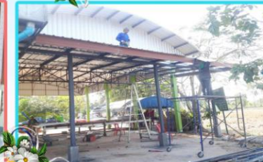
โครงการปรับปรุงต่อเติมหลังคาทรงสูง
