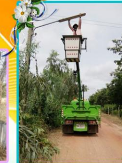
ซ่อมแซมไฟฟ้าส่องสว่าง ในเขตเทศบาลตำบลนาดี
